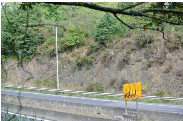
Fig. n°5 : paroi rocheuse en « granit » sur le bord de la rocade avant le passage de la Jonelière.
